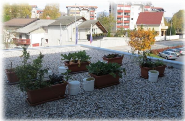
Slika 2: Večja korita na nadstrešku ob vhodu v šolo
