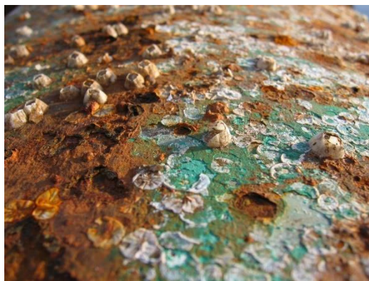
Slika 1 Korozija. Slika pridobljena s: https://sl.wikipedia.org/wiki/Korozija [24. 11. 2019].
