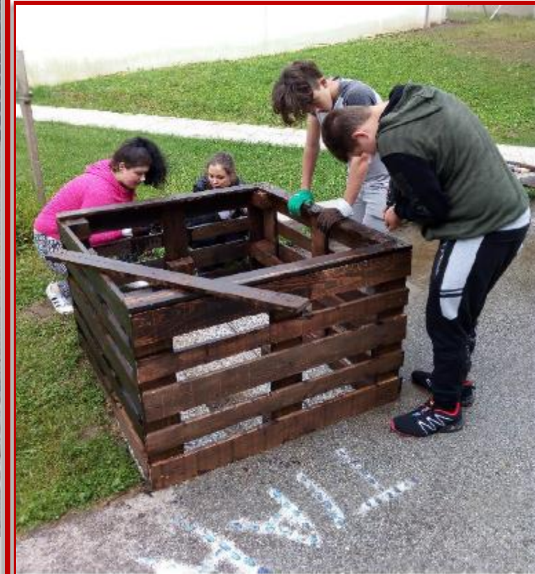
Postavitev konstrukcije na utrjeno podlago.
