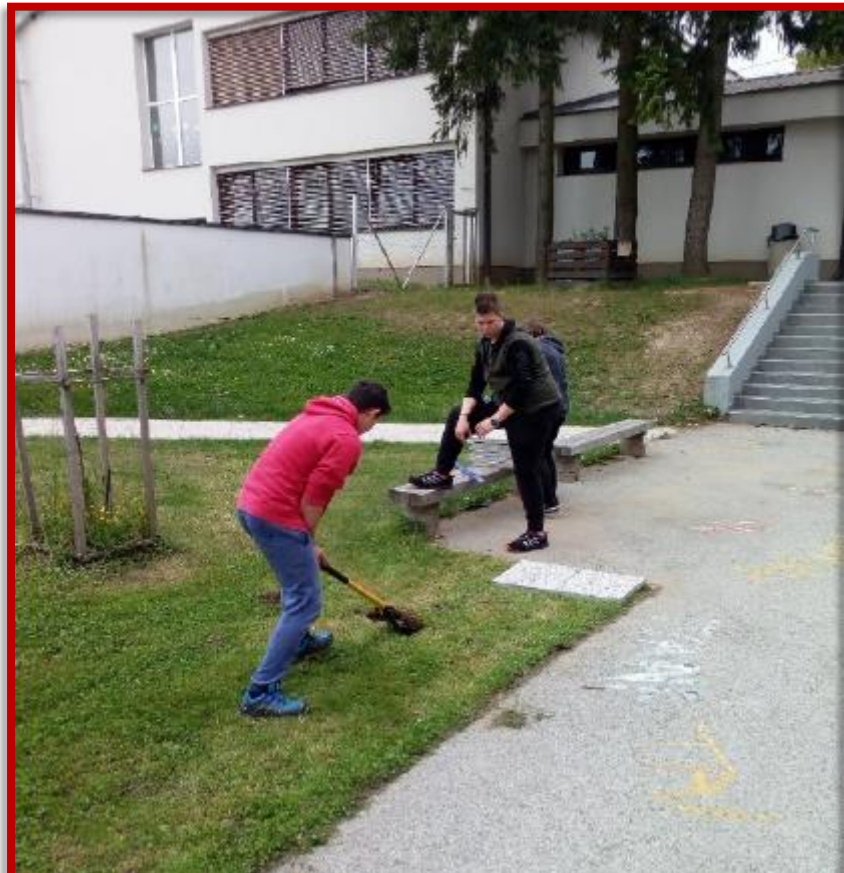
Priprava lokacije postavitve – izkop zemljine.
