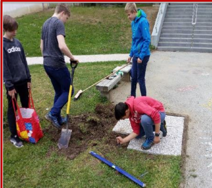
Priprava lokacije postavitve – utrditev in izravnava podlage
