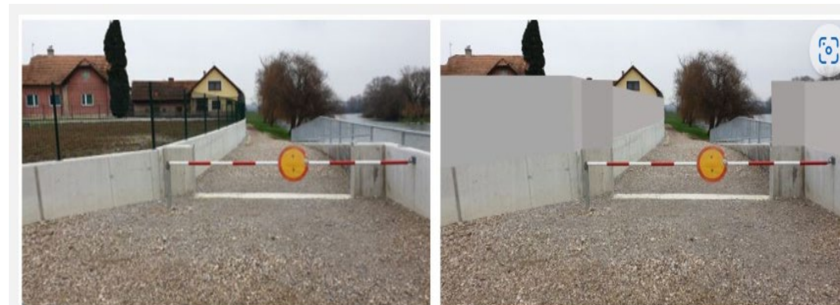
Protipoplavni zid v Krški vasi z dostopom v strugo Krke, ki se ga ob nastopu visokih voda zapre z demontažno pregrado (levo) in simulacija 1,4 m višjega zidu v primeru opustitve gradnje HE Mokrice (desno) (Vir: HE Mokrice, Študija variant, IBE 2020)
