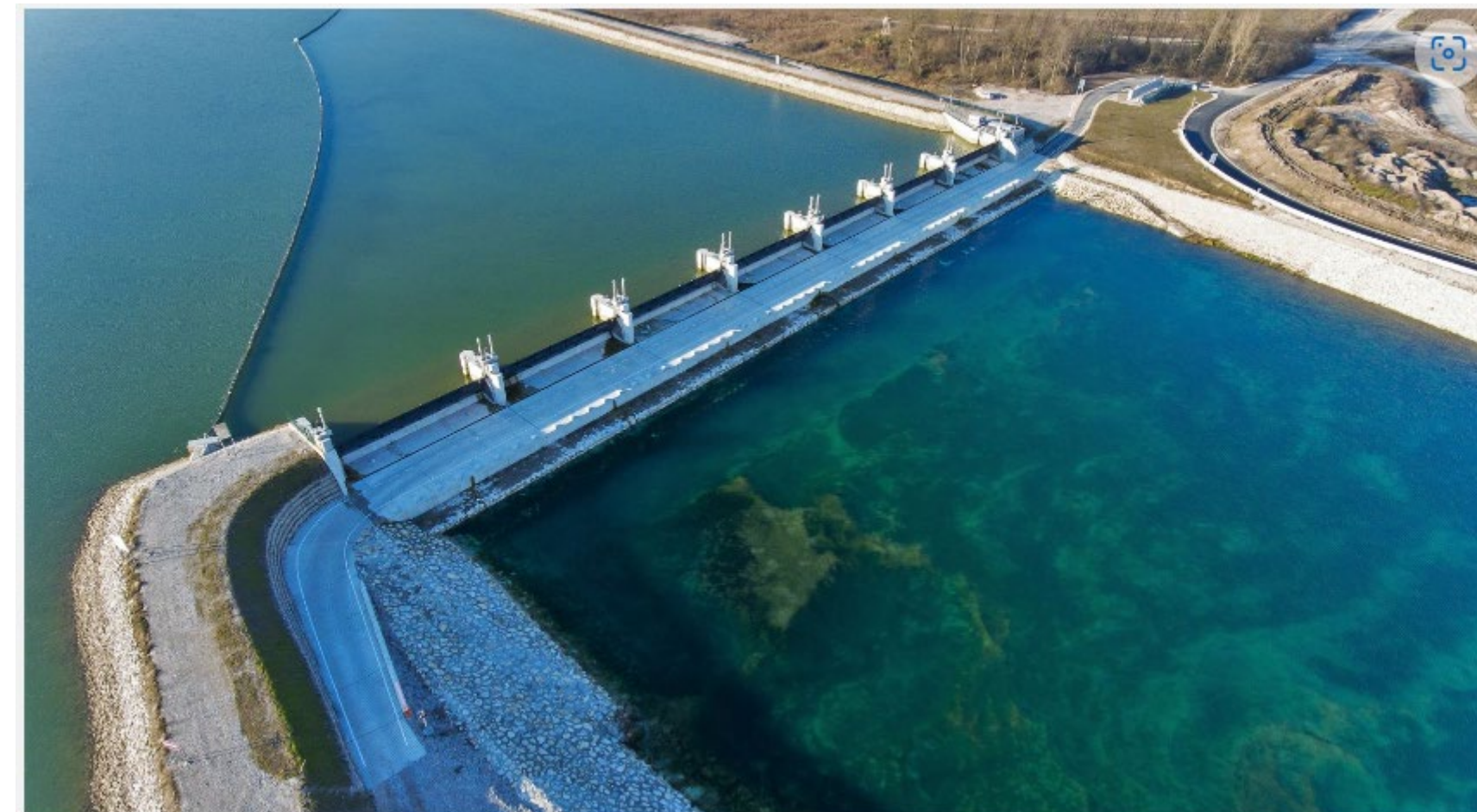
Visokovodni razbremenilnik pri HE Brežice
