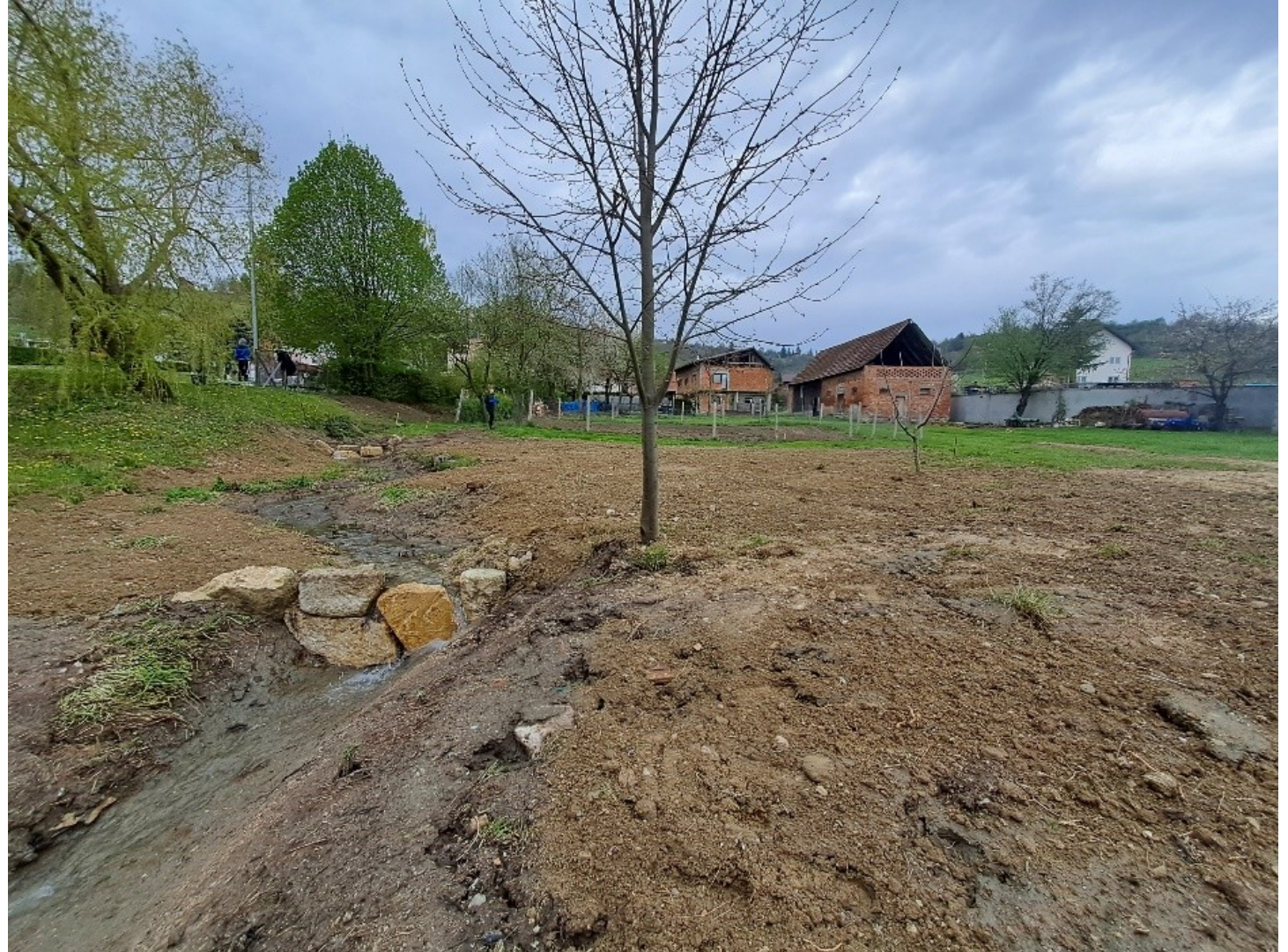
Slika 3. Potok nakon čišćenja i prokopavanja
