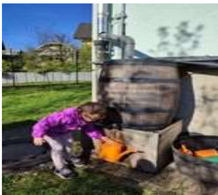
Slika 10: deževnica se zbira v vodnem zbiralniku, nato z njo zalivamo vrt; vir: Nataša Breznik
