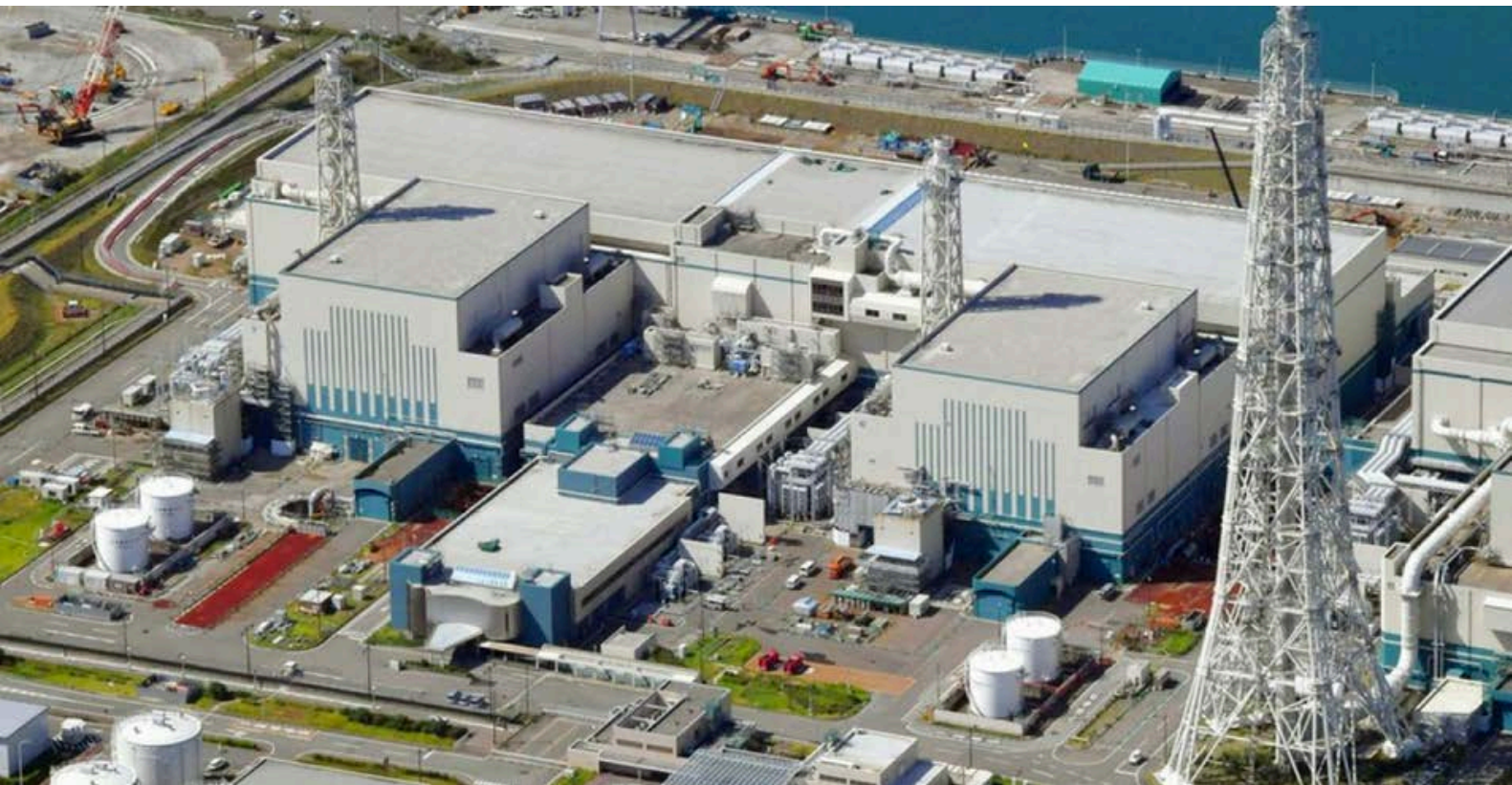
Slika: Največja jedrska elektrarna na svetu - Kashiwazaki - Kariwa na Japonskem (njenih 7 reaktorjev ima nazivno moč več kot 8000 MW) . Vir: Canva
