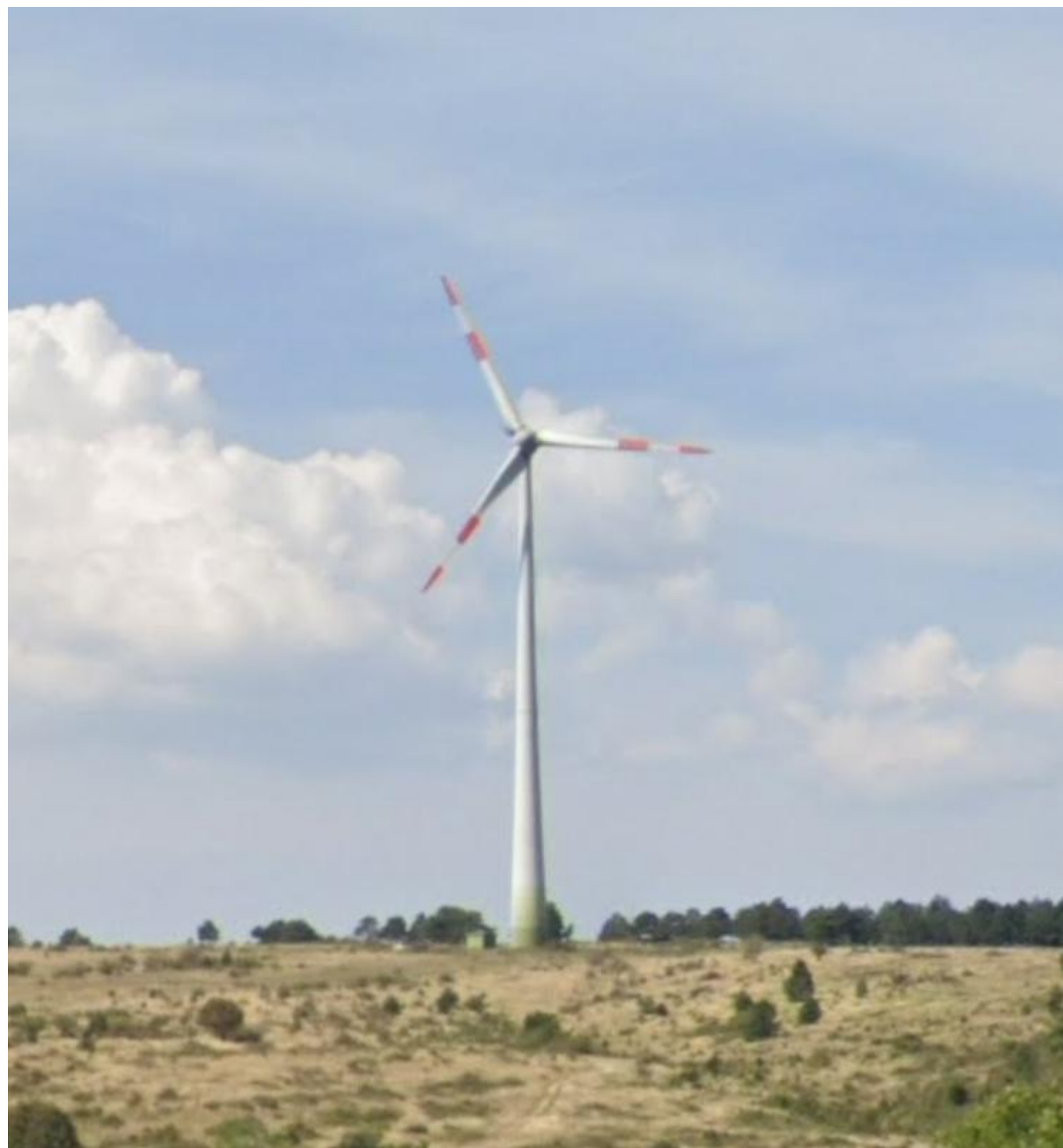
Dolenja vas, Enercon E-70, 2,3 MW, višina stebra 98 m, premer rotorja 71 m
