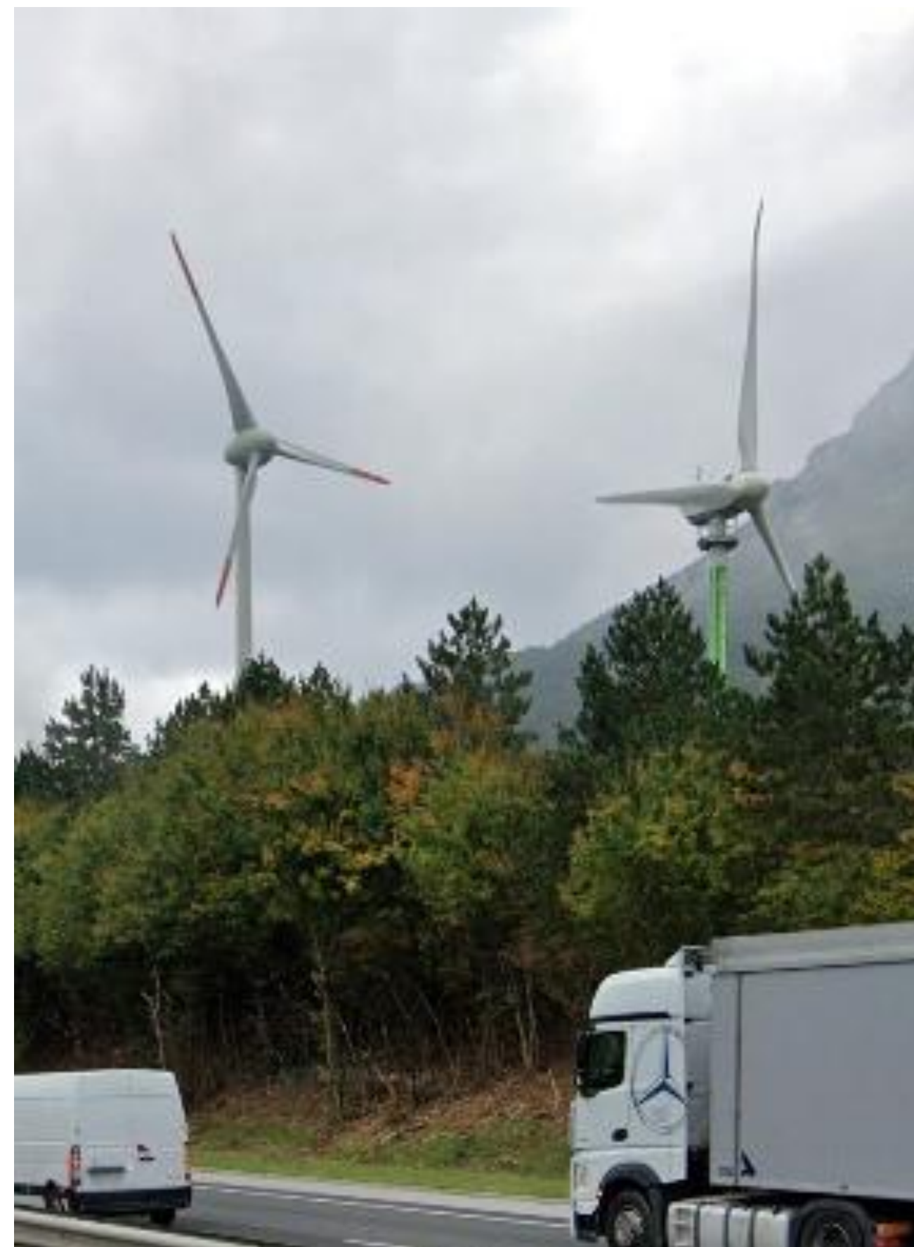
Razdrto I, 900 kW, Enercom E-44, višina stebra 55 m, premer vetrnice 44 m Razdrto II, 250 kW, Leitwind LTW42, višina stebra 28 m, premer vetrnice 42 m
