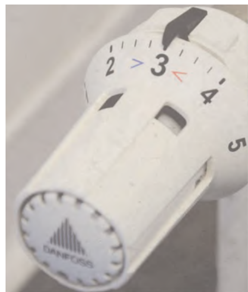
Slika: Termostatski ventil radiatorja Vir: Canva
