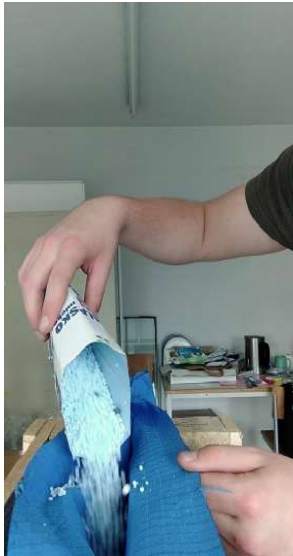
Dodajanje ključne toplotne izolacije
