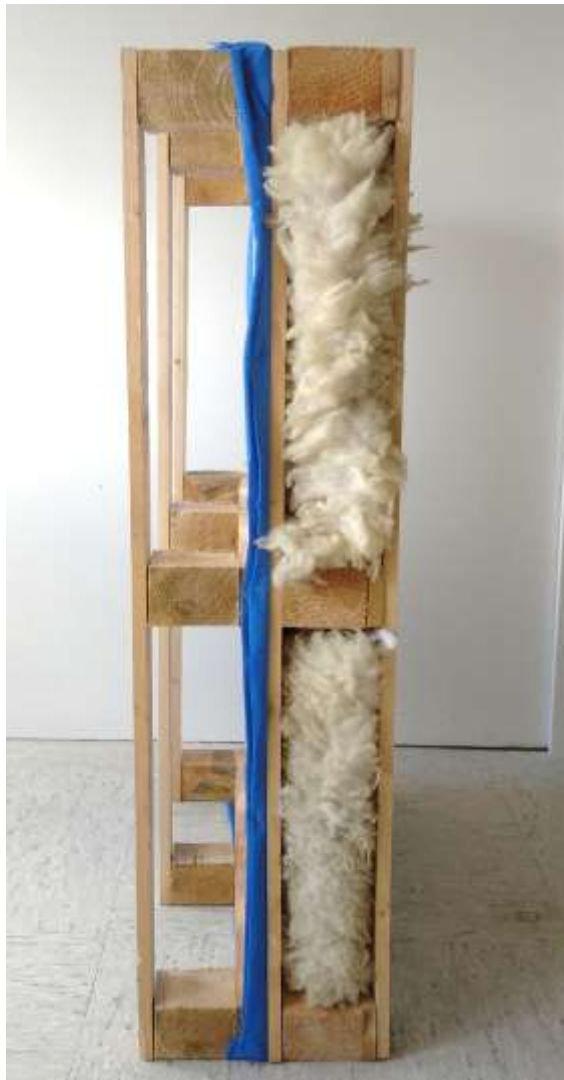
Začetek sestavljanja paletnega sklopa v fasadni element
