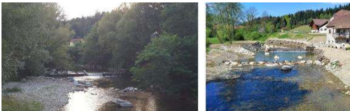
Slika 7: Reka Dreta pri vasi Kokarje, pred (avgust 2025) in po (april 2026) poplavsni obnovi (vir: osebni arhiv)
