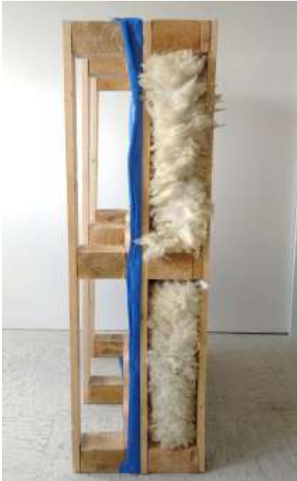
Slika 4: Začetek sestavljanja paletnega sklopa v fasadni element
