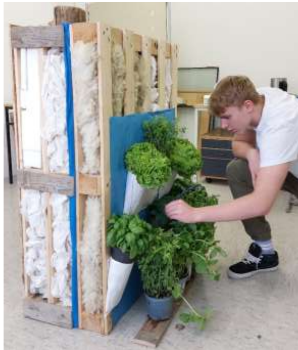
Slika 9: Nameščanje zelene fasade.
